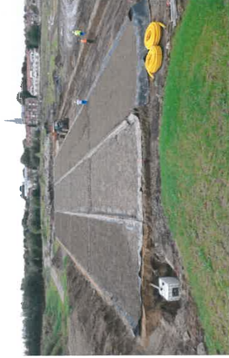
Photographie 9 : Mise en place des plateformes Photographie 10 : Plateforme de phytoremédiation
